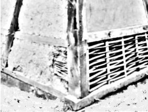
Figuur 1 Vakwerk, vits, lemen met een trekzaag stuk (of recht) gezaagd.
